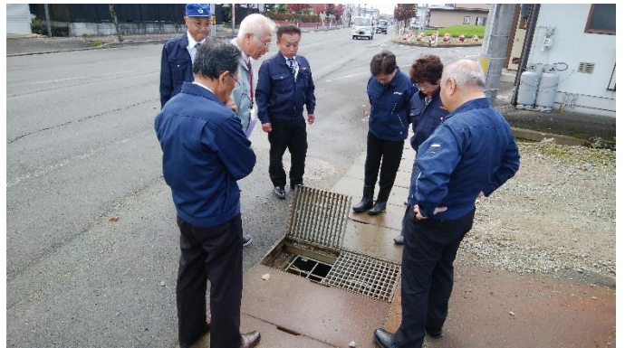
排水路の説明を受けました
