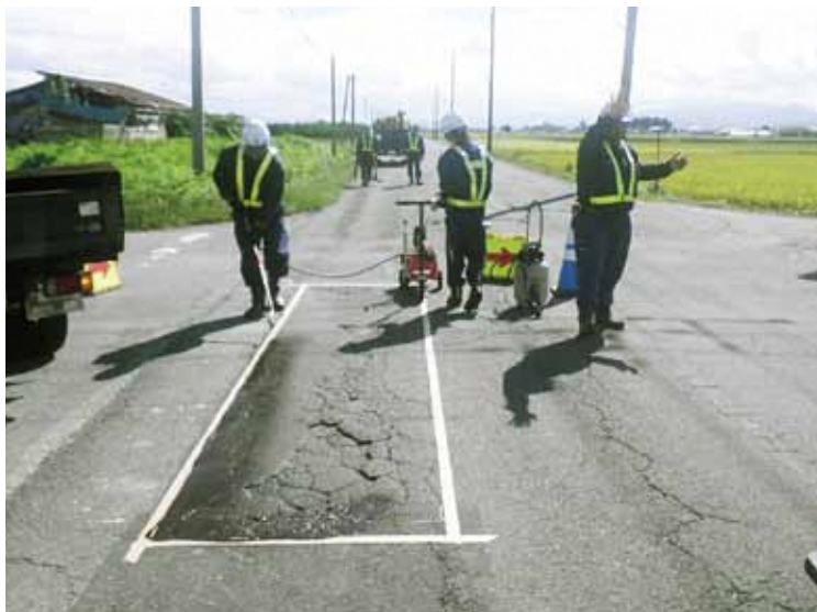
町道の補修作業
