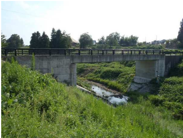
戸の下橋（町道 岩根線 平成14年架設）
