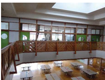
ランチルーム上部吹抜け
