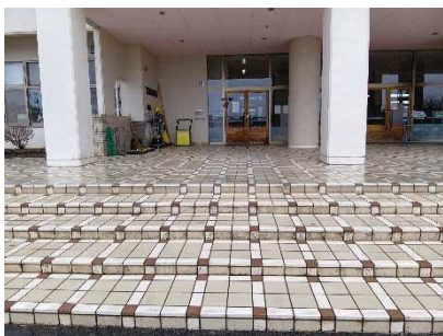
昇降口まわりのピロティ
