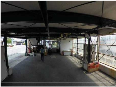
ピロティ 駐車場
