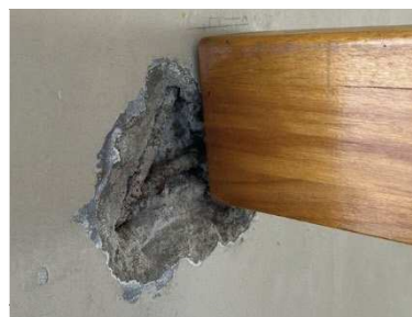
階段手摺端部付近の壁
