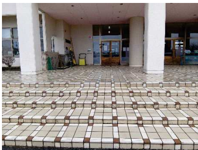
昇降口まわりのピロティ
