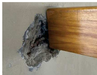
階段手摺端部付近の壁
