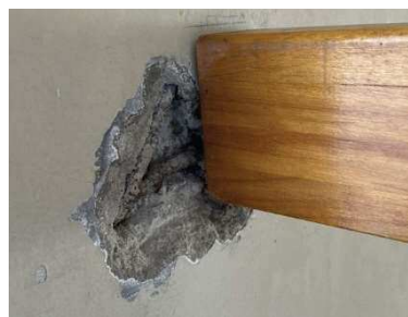
階段手摺端部付近の壁
