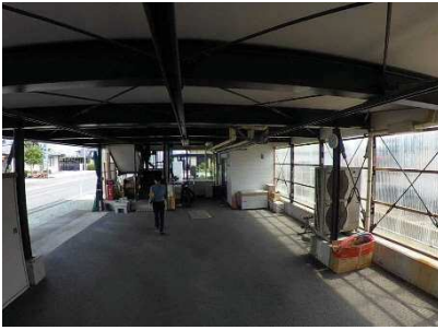
ピロティ 駐車場
