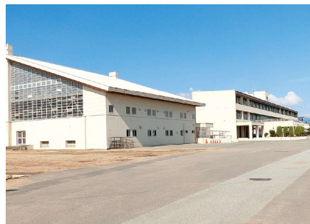
老朽化が進んでいる河北中学校
