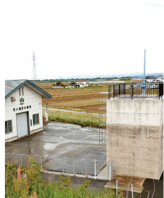
吐出水槽がかさ上げされ排水能力が向上した荒小屋排水機場
