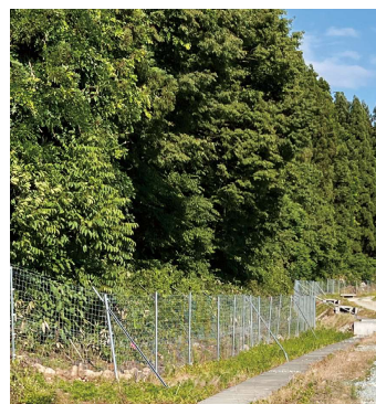
侵入防止柵の設置例
