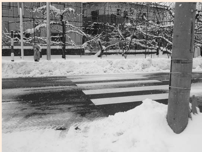
除雪されていない歩道
