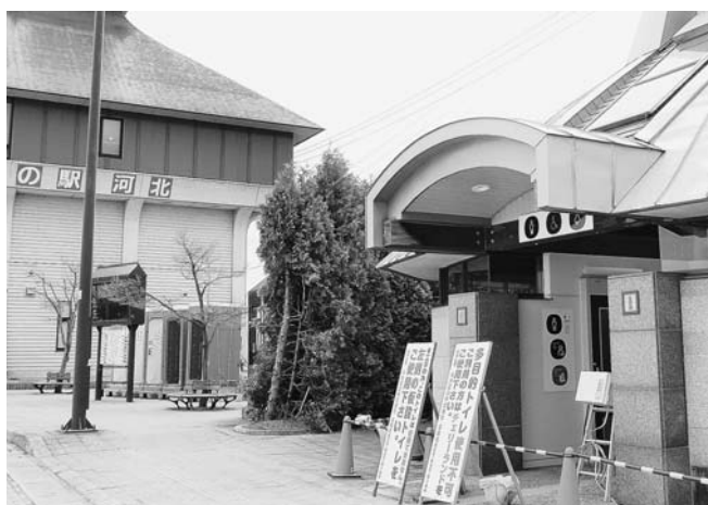
道の駅河北のトイレ改修
