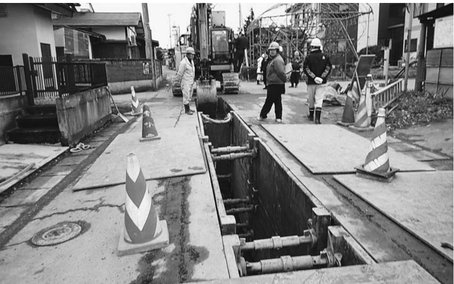
下水道の工事
