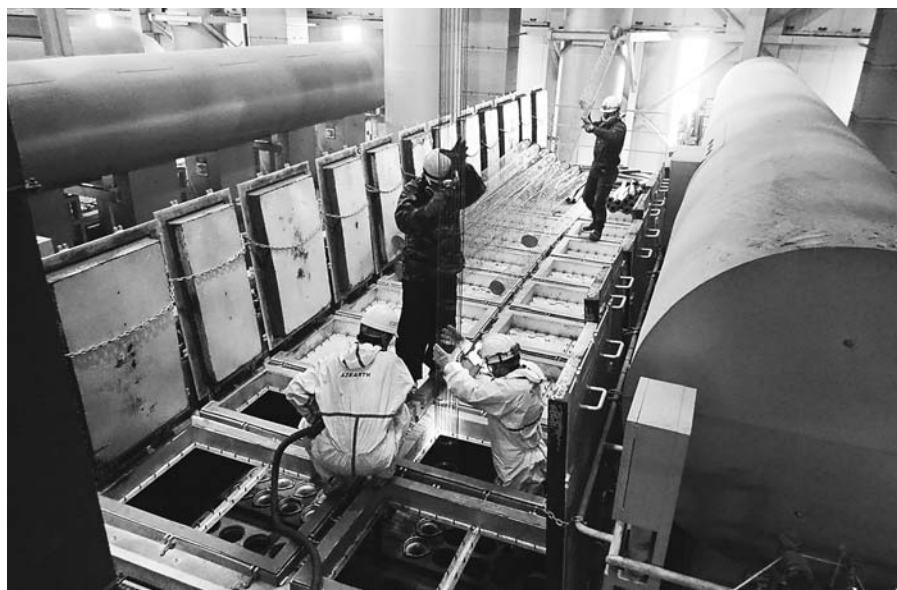
ごみ焼却処理施設延命化工事(クリーンピア)
