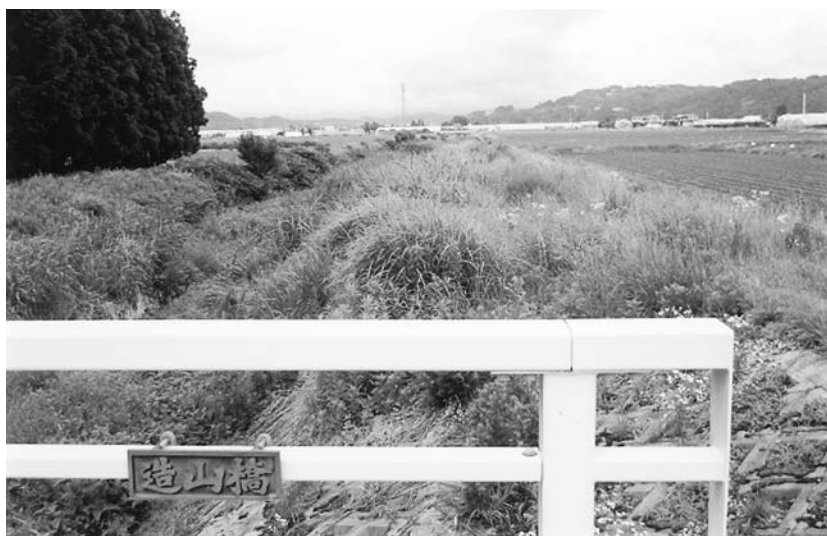
槇川・造山橋付近の繁茂した河川内の草木
