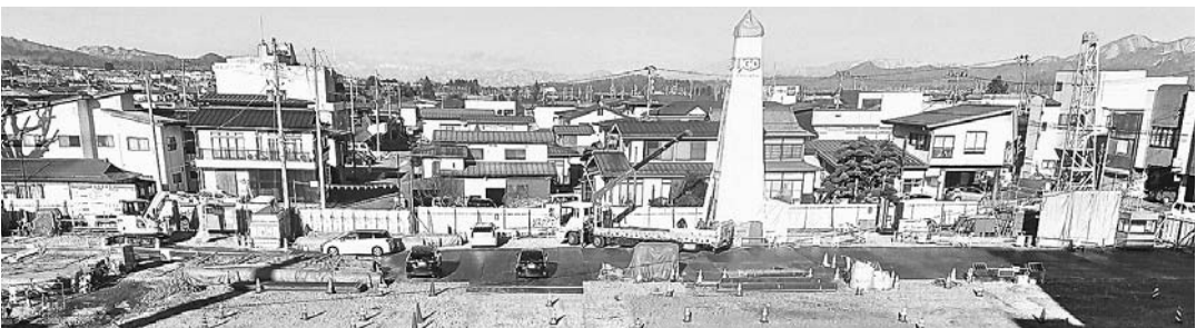
新方式の杭打ち工事待った 新庁舎建設現場
