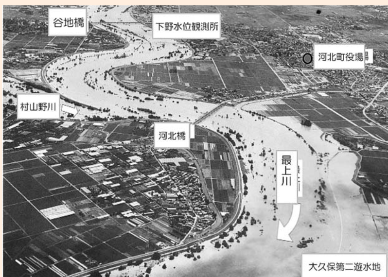
平成14年7月11日 台風6号による出水状況
