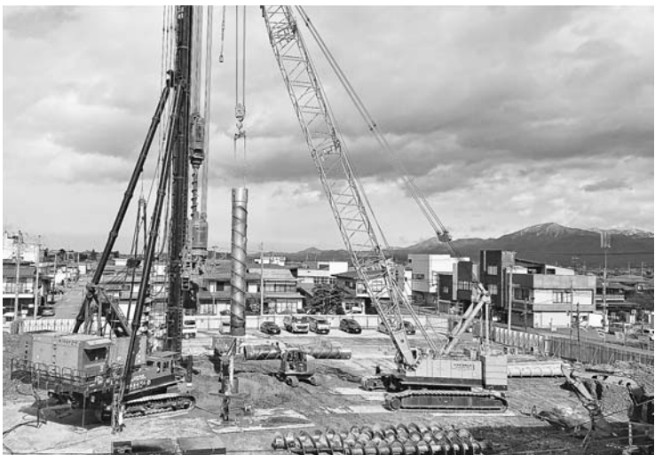
新工法で杭打ちが進む新庁舎建設
