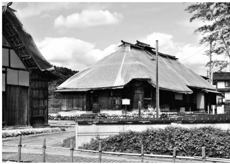
養生して工事を待つ八景庵
