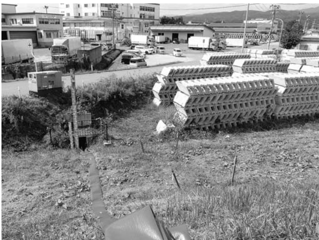
谷地工業団地に仮設された排水ポンプ
