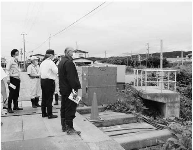
押切の仮設の発電機とポンプ
