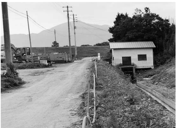
堤防の高さまでの吐出水槽が必要な押切の排水機場
