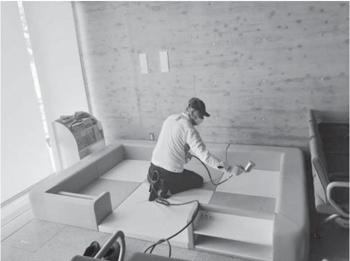
抗菌施工中のキッズコーナー(庁舎1階)
