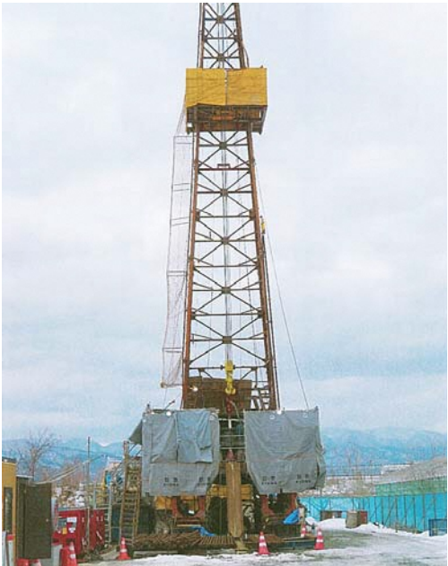
天童市のゆびあ第3源泉掘削工事
