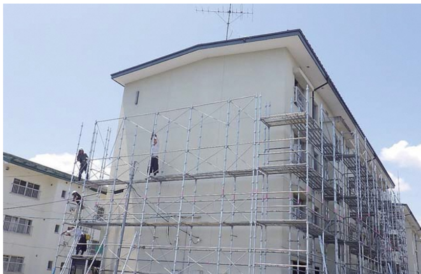
町営東団地の長寿命化工事
