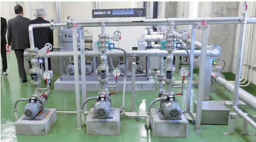
治部橋水源地の内部
