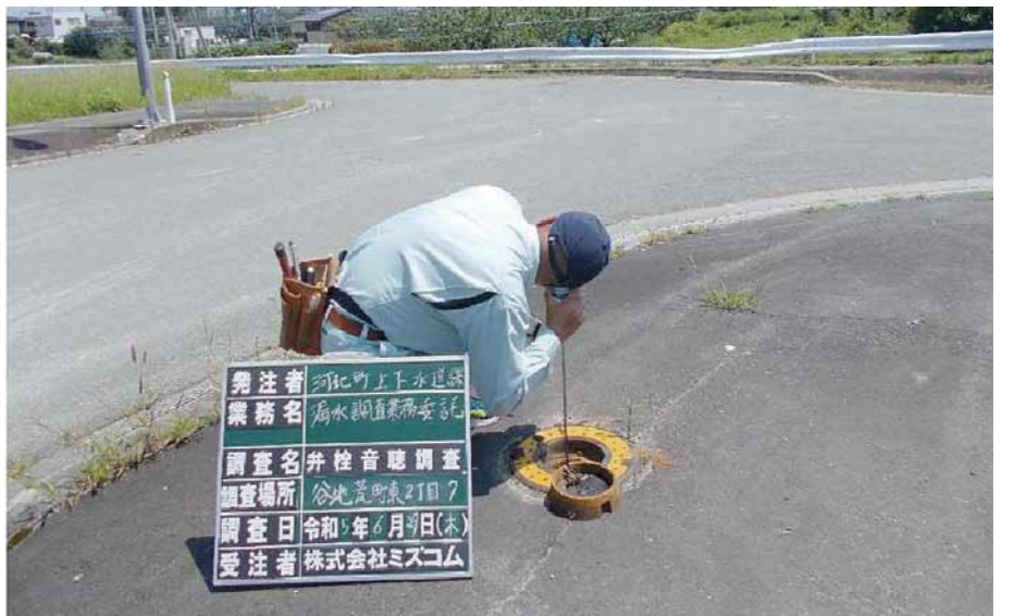
漏水の音聴調査
