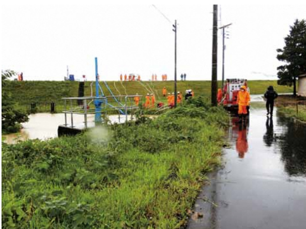
押切の排水機場は改良が進んでいる
