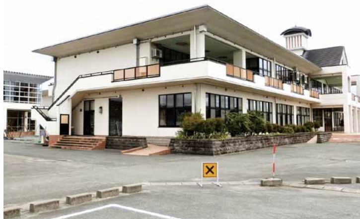
建設後21年でまだまだ使える谷地中部小学校
