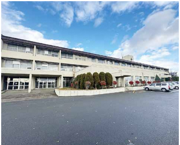
整備が検討されている河北中学校
