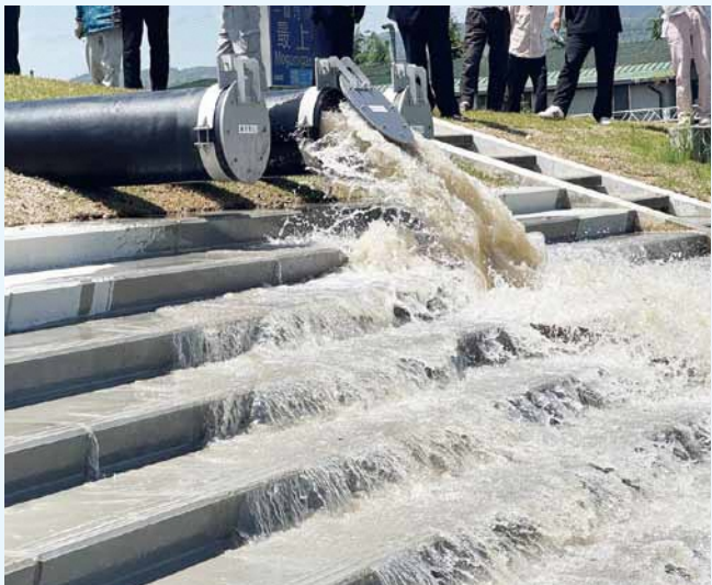
押切排水機場ポンプの試運転
