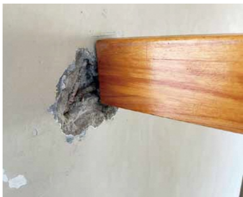
傷んでいる河北中の階段手摺の壁 (基本構想・基本計画(案)からの引用)
