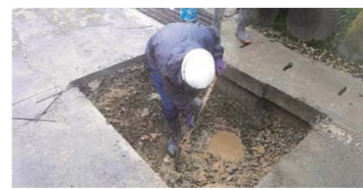
漏水の修繕工事
