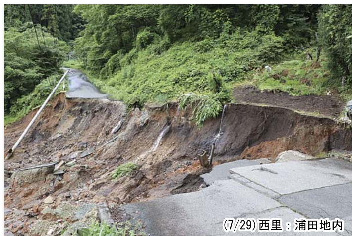
(7/29) 溝延：泊川地内
