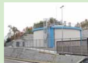
上水道配水池
