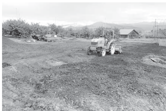
樹木などの撤去・整地を支援します。
